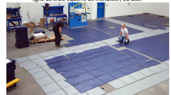
Pic 4. Diviser la palette et de répartir les tuiles sur le plancher avant de commencer l'installation.
