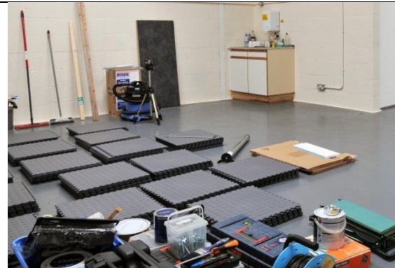
Pic 1. Décomposer les palettes et de permettre carreaux de s'acclimater
