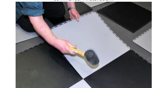
Pic 5. Ne pas forcer les dalles, tapez doucement l'angle et les joints de la dalle.
